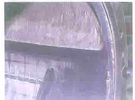
Abb. 4: Hartverchromtes Schleusengehäuse nach ca. 10.000 h Einsatz (Fördergut: Dolomit mit 10 % SiO 2 )
