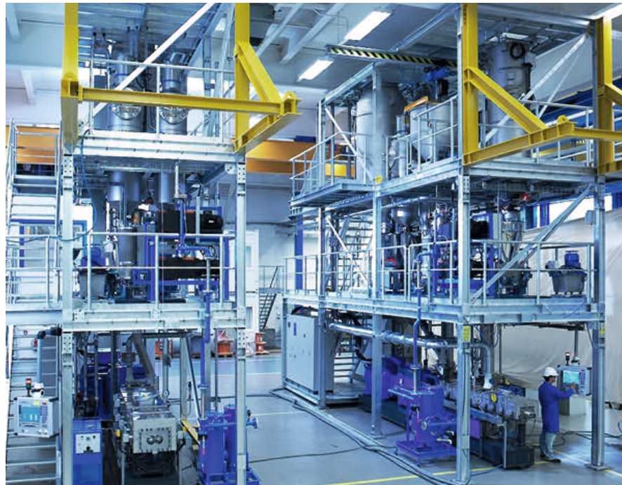
Gesamtanlage zum Compoundieren von Thermoplastischen Elastomeren (Bilder: Coperion)
